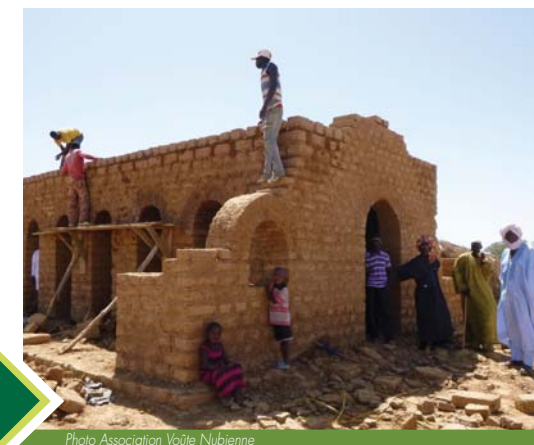
Photo Association Voûte Nubienne
