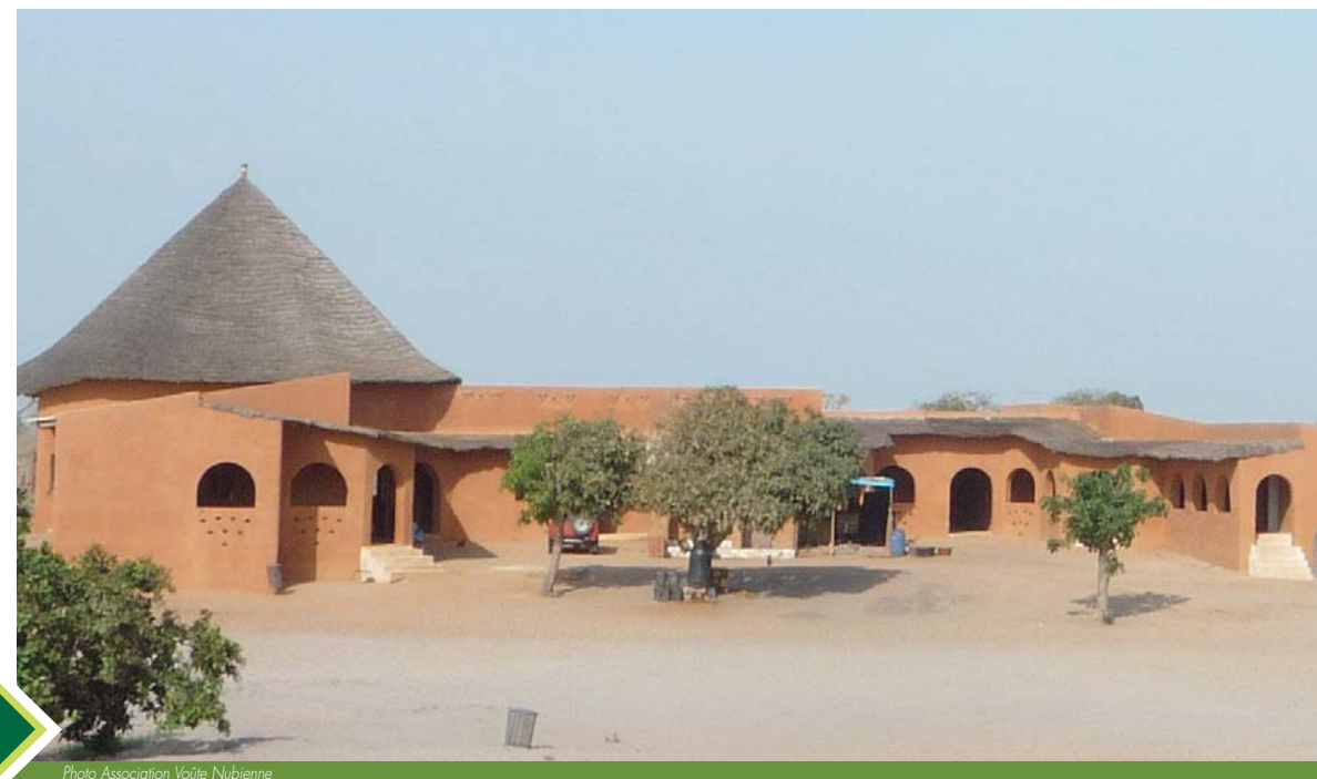
Photo Association Voûte Nubienne
