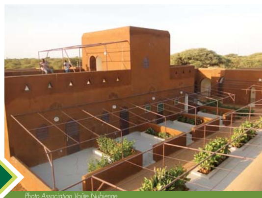
Photo Association Voûte Nubienne
