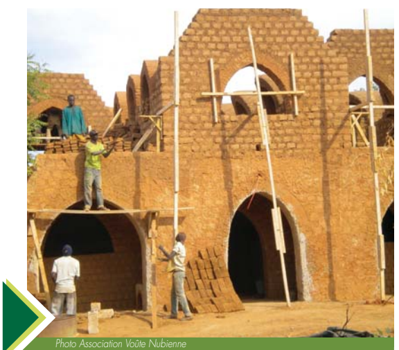
Photo Association Voûte Nubienne
