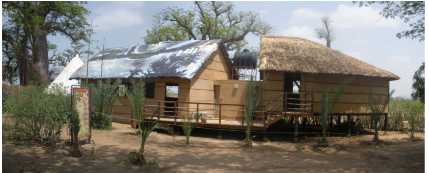
Logements d'accueil du parc AccroBaobab, Sindia
